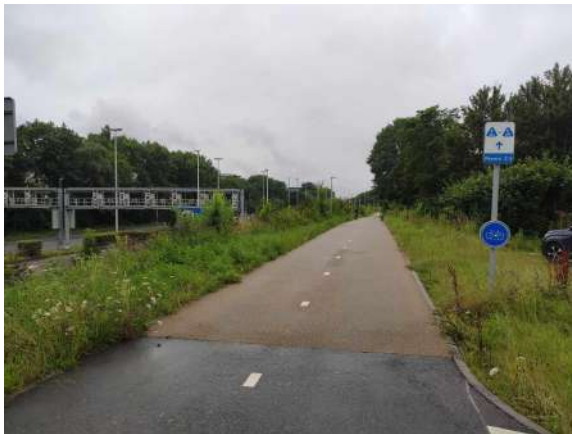
Raccordement entre réseaux bruxellois et flamand proche de l'E40
